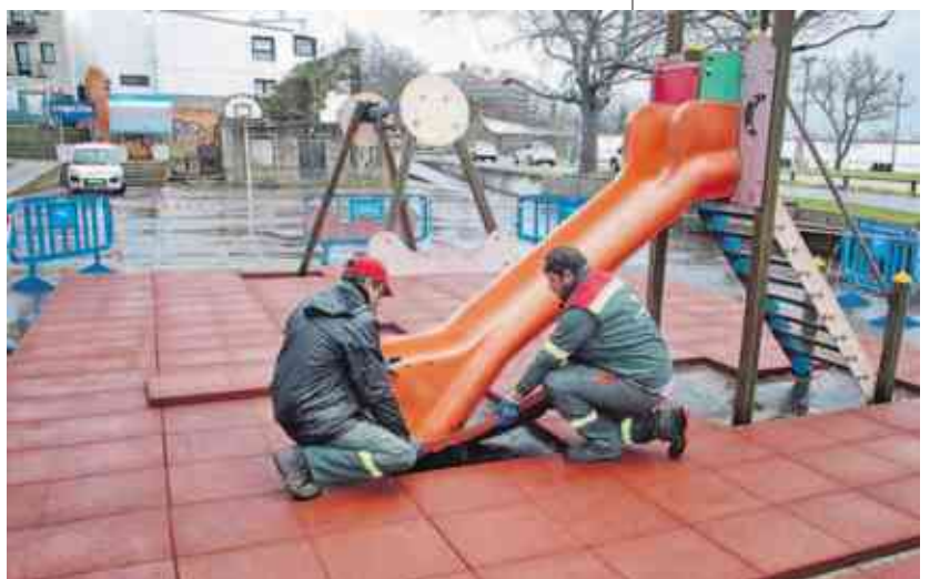
Dos operarios trabajaban ayer en la reposición de las losetas de caucho del parque de Ferrol Vello. J. PARDO
